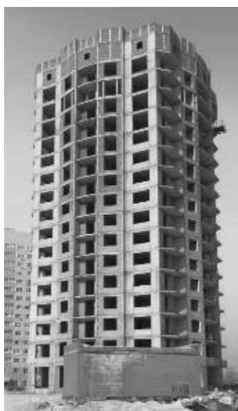
Рисунок 1 – Наружный вид жилого дома на момент начала проведения обследования
