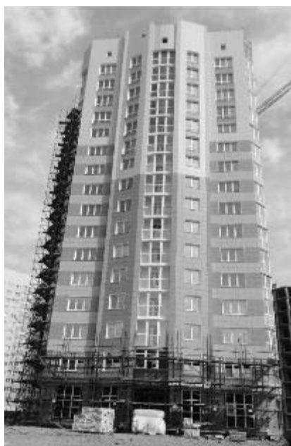
Рисунок 2 – Наружный вид жилого дома на стадии возобновления строительства
